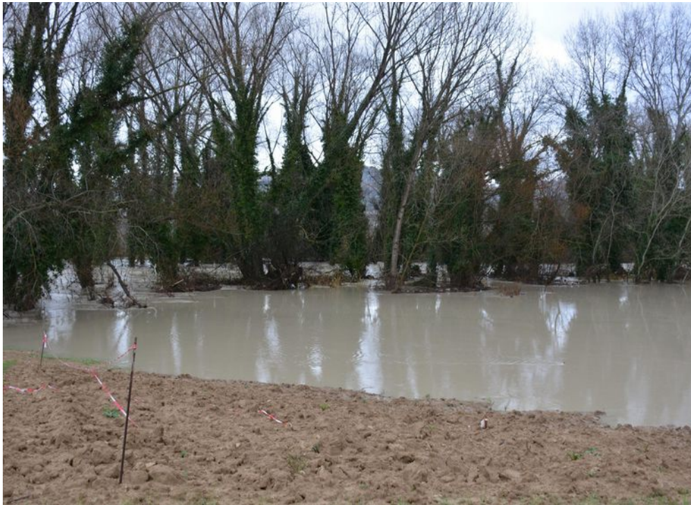
Cantiere 15 – si noti il tondino d'angolo (che spunta di qualche centimetro) in piena corrente
