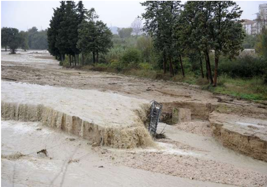
Marche – fiume Chienti – traliccio crollato nel letto del fiume: http://foto.ilmessaggero.it/italia/maltempo-a-macerata-straripa-il-fiume-chienti-fattorie-allagate-foto-calavita/0-57058.shtml
