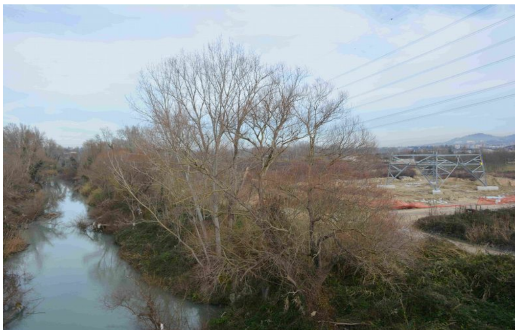
Visione d'insieme del cantiere del sostegno 18N
