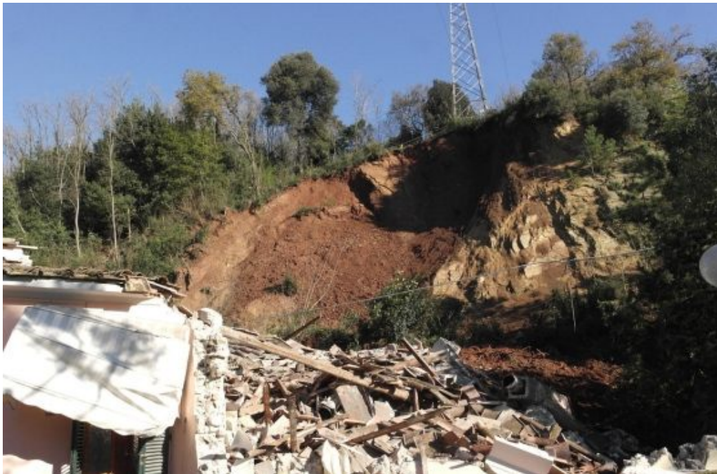
Toscana, traliccio su frana a Ripafratta, poi smontato il 9 gennaio 2015: http://iltirreno.gelocal.it/pisa/cronaca/2015/01/09/news/rimosso-il-traliccio-di-terna-dalla-collina-della-frana-1.10635067
